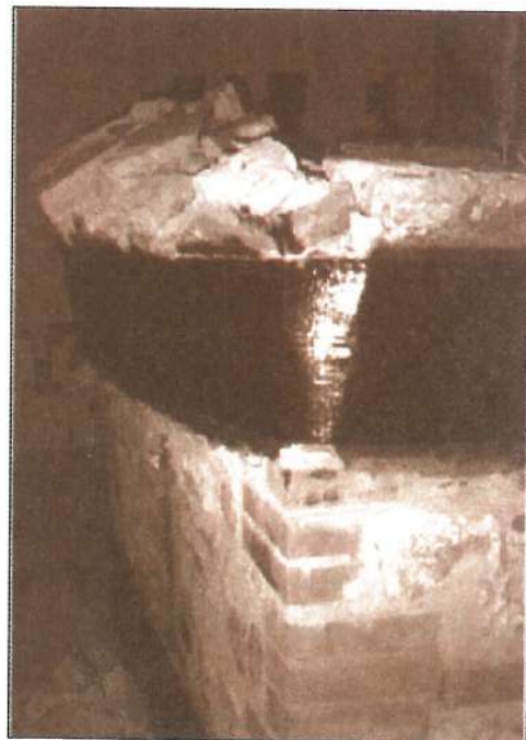
شکل ۲: کار آبی لایه کامپوزیت‌های پایه پلیمری (FRP) تا فرو ریختن دیوارهای آجری
