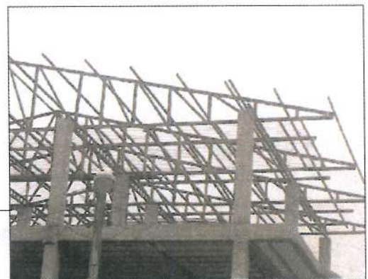
نمونه‌هایی از اجرای سربندی (خرپاهای پوششی) بدون اجرای کلاف افقی
