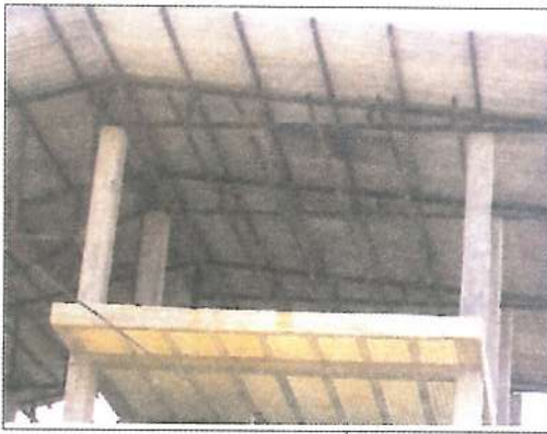
اتمام عملیات پوشش سقف شیب دار بدون اجرای کلاف افقی در آخرین تراز
