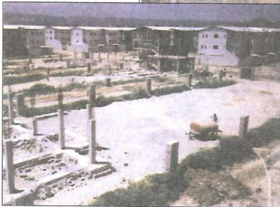
کارگاه مجتمع مسکونی کارکنان دولت قائم شهر
