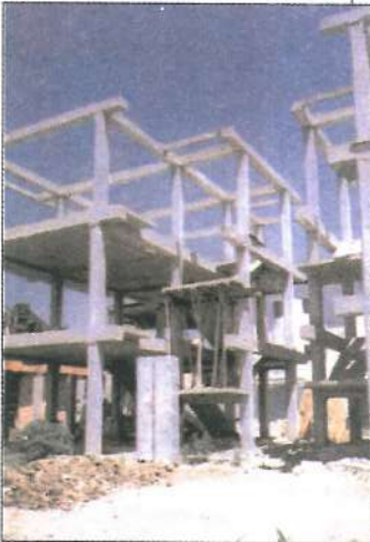
اجرای کامل اسکلت قبل از اجرای خرپای آخرین سقف
