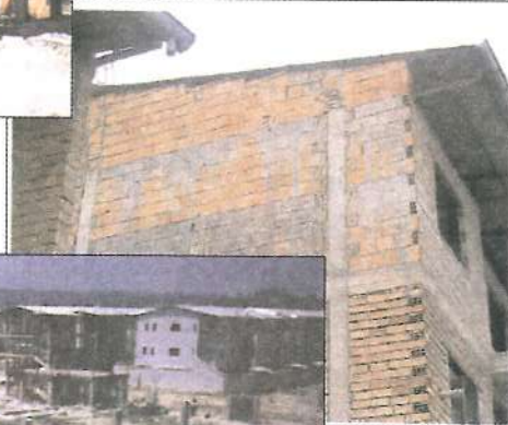
اجرای کامل اسکلت قبل از اجرای خرپای آخرین سقف
