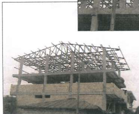
نمونه‌هایی از اجرای سربندی (خرپاهای پوششی) بدون اجرای کلاف افقی
