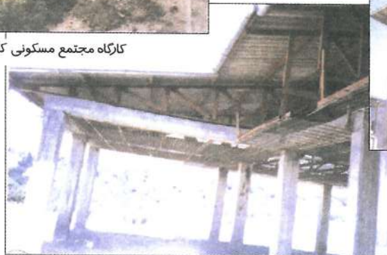
اجرای مناسب سرپندی (خرپاهای پوششی) همراه با اجرای کامل کلاف‌های افقی آخرین تراز، نصب پلیت قبل از شن‌ریزی و تأمین جوش مربوط به خرپاها
