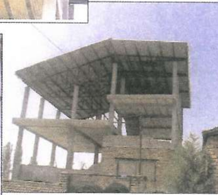
اتمام عملیات پوشش سقف شیب دار بدون اجرای کلاف افقی در آخرین تراز
