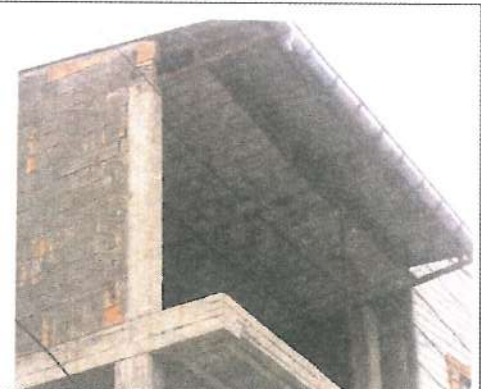
نمونه‌های دیگری از اجرای سقف شیب دار آخرین تراز
