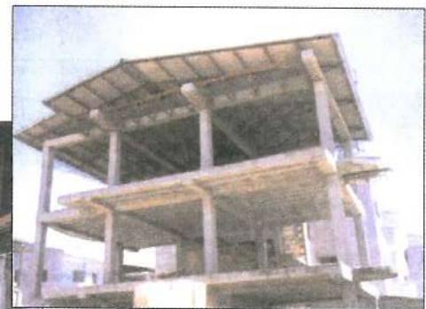
اجرای کامل اسکلت- به همراه خرپای آخرین تراز اجرایی
